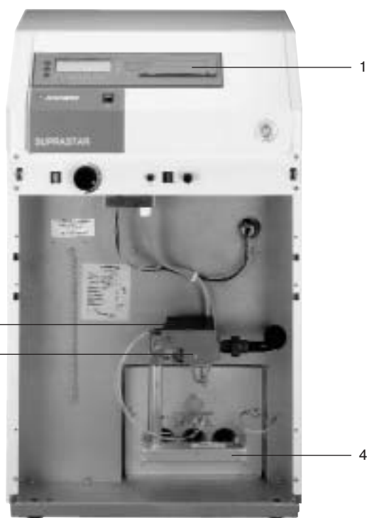
4. ábra – Suprastar KN...-8 DP állókazán burkolat nélkül
